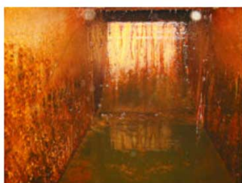
Normalmente, el canal es de difícil acceso
